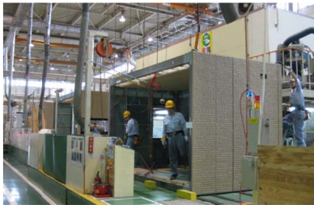
Abbildung 5: Individueller Ausbau vorgefertigter und hochinstallierter Wohneinheiten auf dem Fließband in Japan.
