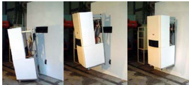
Abbildung 3: Voll funktionsfähige experimentelle 1:1-Modelle intelligenter Service-Subsysteme des Room-in-room-Typs, die mittels standardisierter Plug&Play Schnellverbinder physisch und informationstechnisch an das Gesamtsystem angebunden werden.
